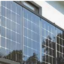
Südost und Südwest Fassade
